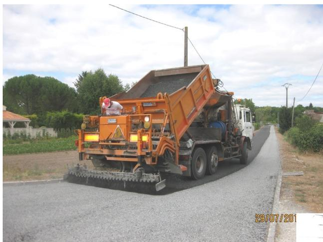
↳ Du Pont des Allards au carrefour de la Pouchaume : réfection de la chaussée qui s'était affaissée autour des tampons d'assainissement .
