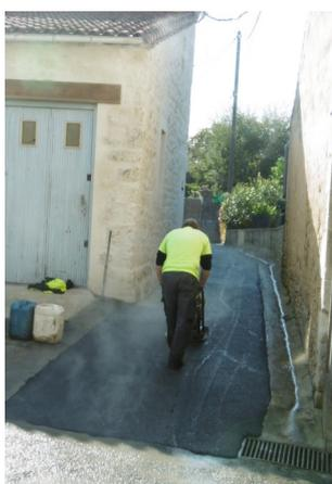
Mise en place d'un enrobé à chaud plus pose de potelets évitant d'entraver le cheminement des piétons.
