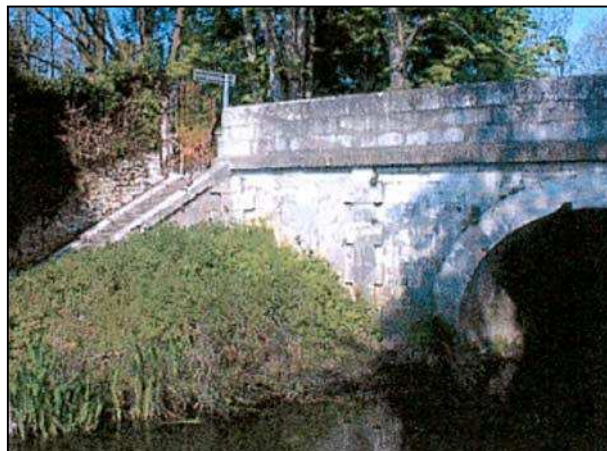
Le premier accès de l'avenue du Maréchal Leclerc au canal se fait par un escalier de pierre pris dans l'appareillage du pont.
