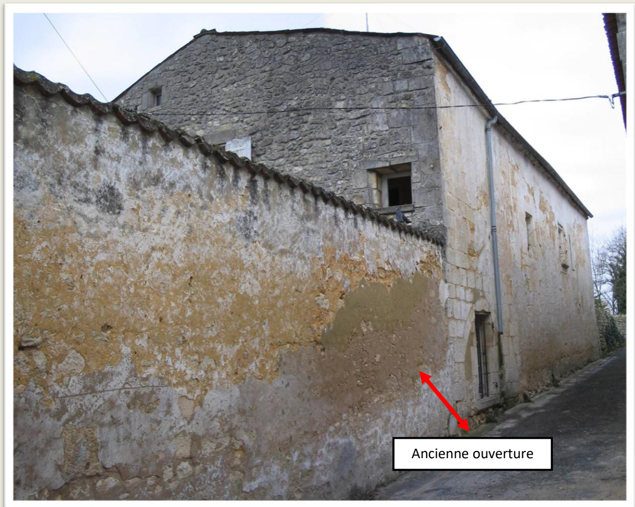
Presbytère le long de la rue du Sénéchal
