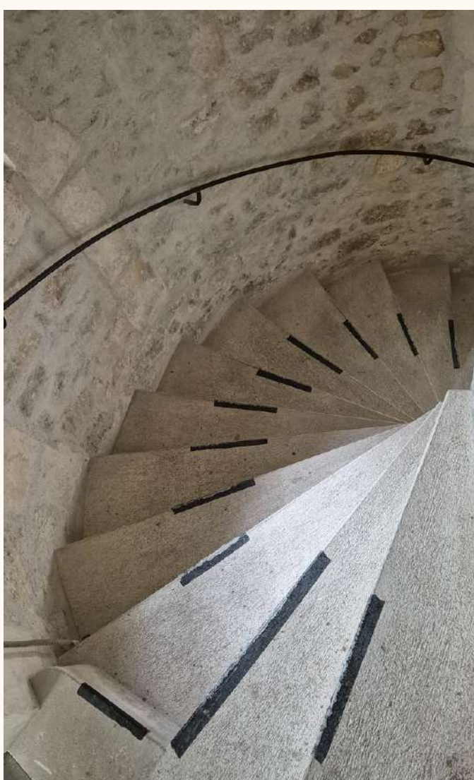
POUR ACCÉDER À L'ÉTAGE, IL Y A UN ESCALIER EN GRAND COLIMAÇON DE 3,16 M DE DIAMÈTRE INTÉRIEUR
