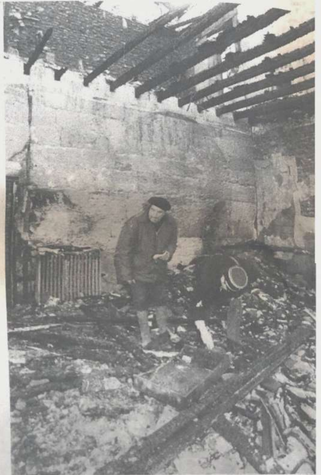
Ce qui reste des salles rénovées il y a quelques mois.
